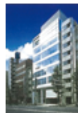
千代田テクノル 本社ビル
