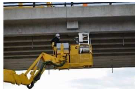
橋梁点検車に搭載可能な理研発、インフラ非破壊検査
