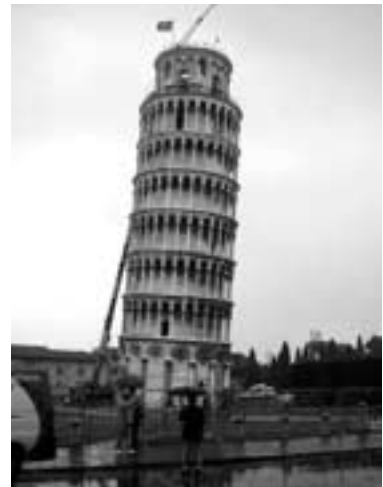
補強工事の終わったピサの斜塔全景
