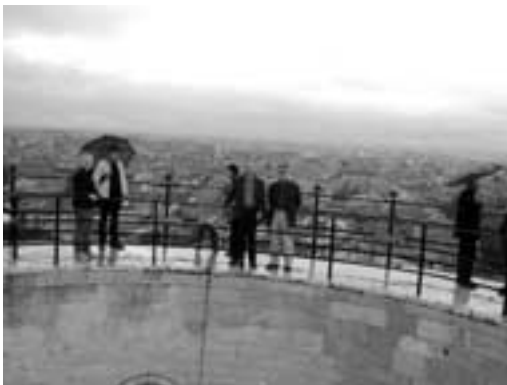
ガリレオが実験をしたと思われる斜塔の屋上
