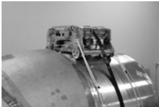
配管に取付けられた超音波探傷検査装置
