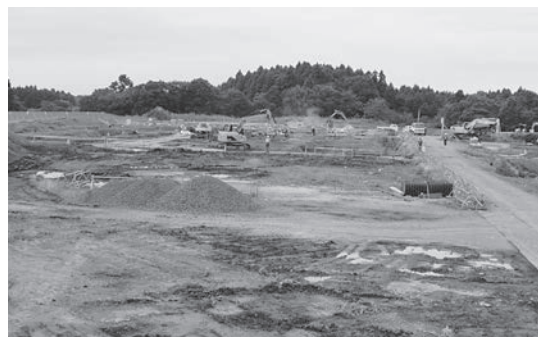
写真-3 大貫台事業所の建設現場。基礎工事が始まったばかりの時点です。
