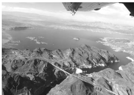
図4 フーバーダム
