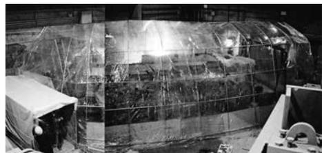
図4 生体遮蔽体の放射化部分のグリーンハウス内での撤去作業
