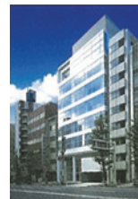
千代田テクノ 本社ビル
