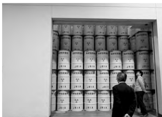
写真4 200ℓドラム缶保管の様子
