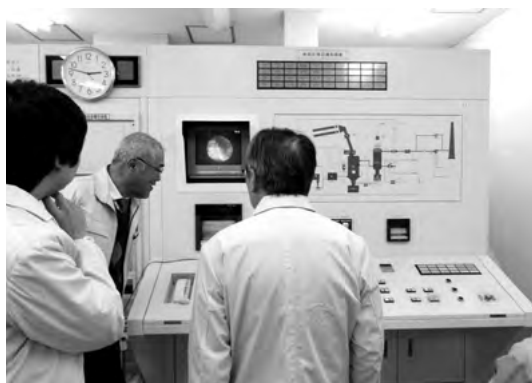
写真8 制御室 普段は1名で作業されています。
