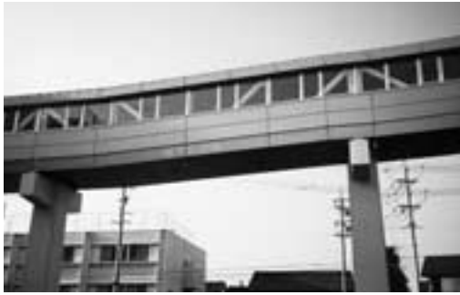
木沢記念病院と中部療護センターを結ぶ3階通路
