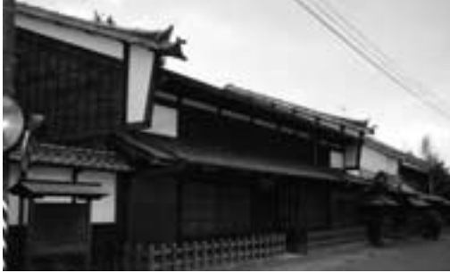
重要文化財に指定されている建築物
