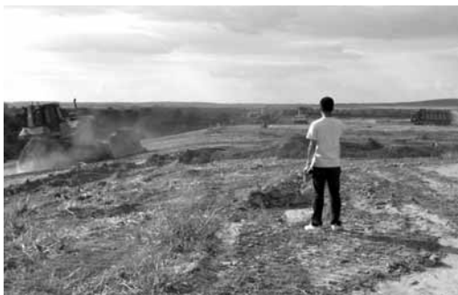
図2 Tailing pond に盛り土の作業をしている現場
