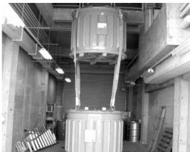
写真－6 吊り上げ荷重検査
