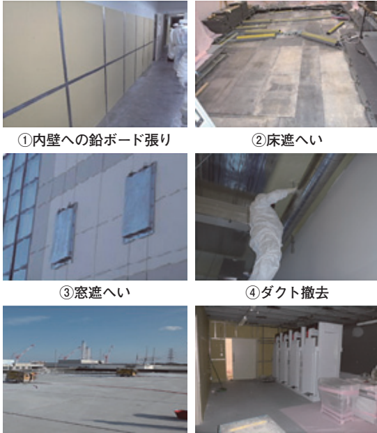
写真 5. 免震重要棟緊急時対策室の非管理区域化工事
