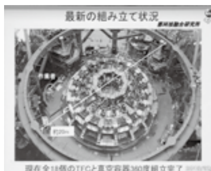
写真4 設備の組み立て状況説明
