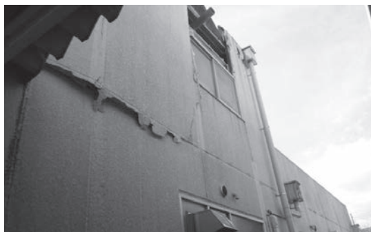
福島営業所外壁
