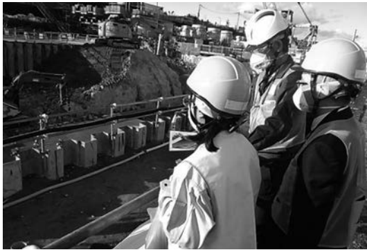
写真1 上流水槽設備の掘削現場
