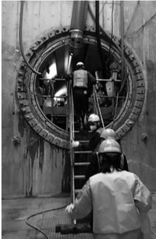
写真2 トンネル入り口
