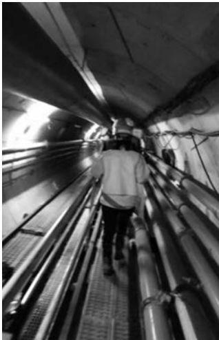
写真3 トンネル内の様子。足場があり、泥水を送る管・戻す管、風管がある。
