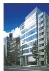
千代田テクノル 本社ビル
