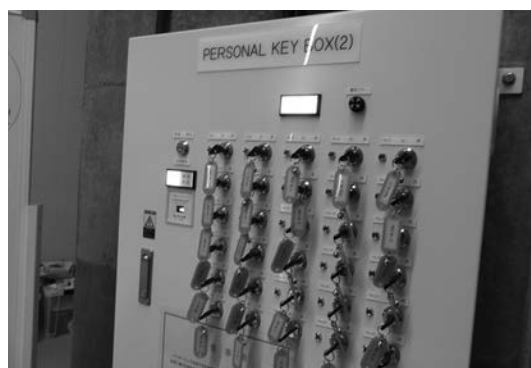
Fig.12 放射線安全インターロックの一例
