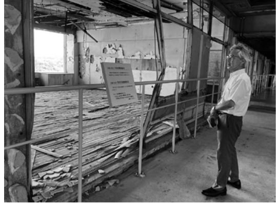
図13 津波により損壊した教室
