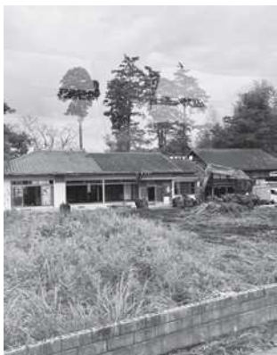
図2 放射線による汚染により、震災当時の様子をとどめる住宅
